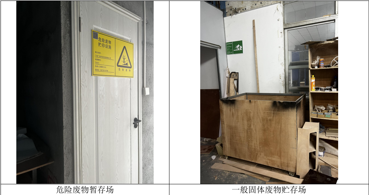
图 4.1-8 固体废物暂存场所现场照片
