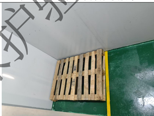
专用危险废物暂存场地面硬化及防渗
