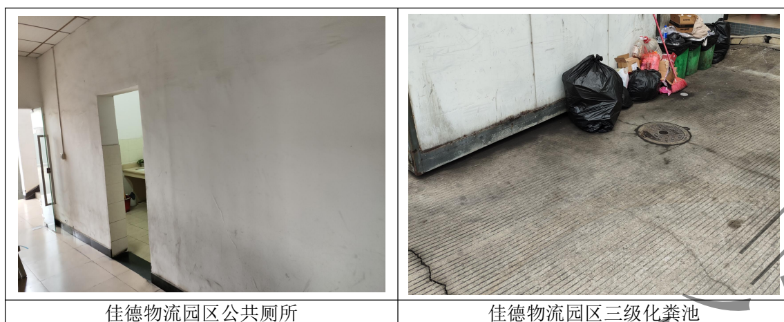
图 4.1-1 废水治理设施现场照片
