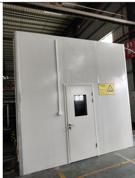
危险废物暂存场 TS001 远照
