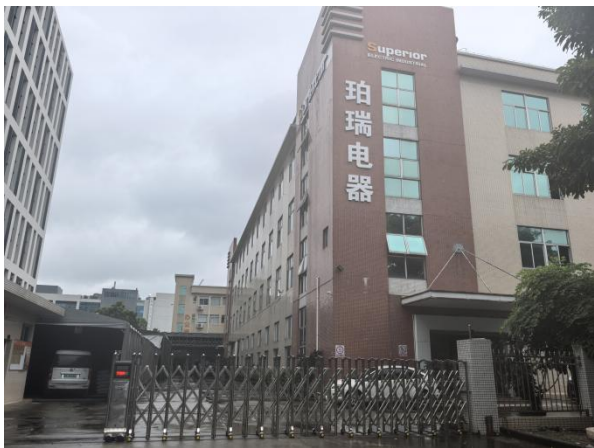
南侧 广州珀瑞电器实业有限公司 11m
