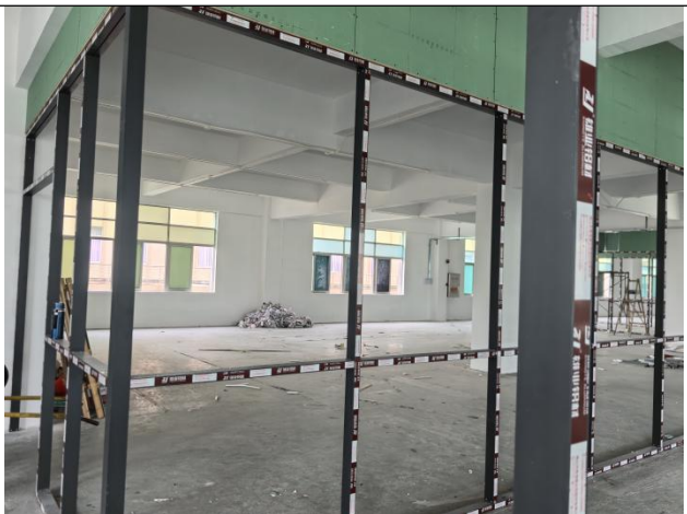
项目内部现状 第二层
